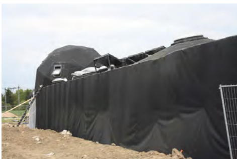
Aan de noordzijde van de bandenwanden komen nog aarden wallen.
