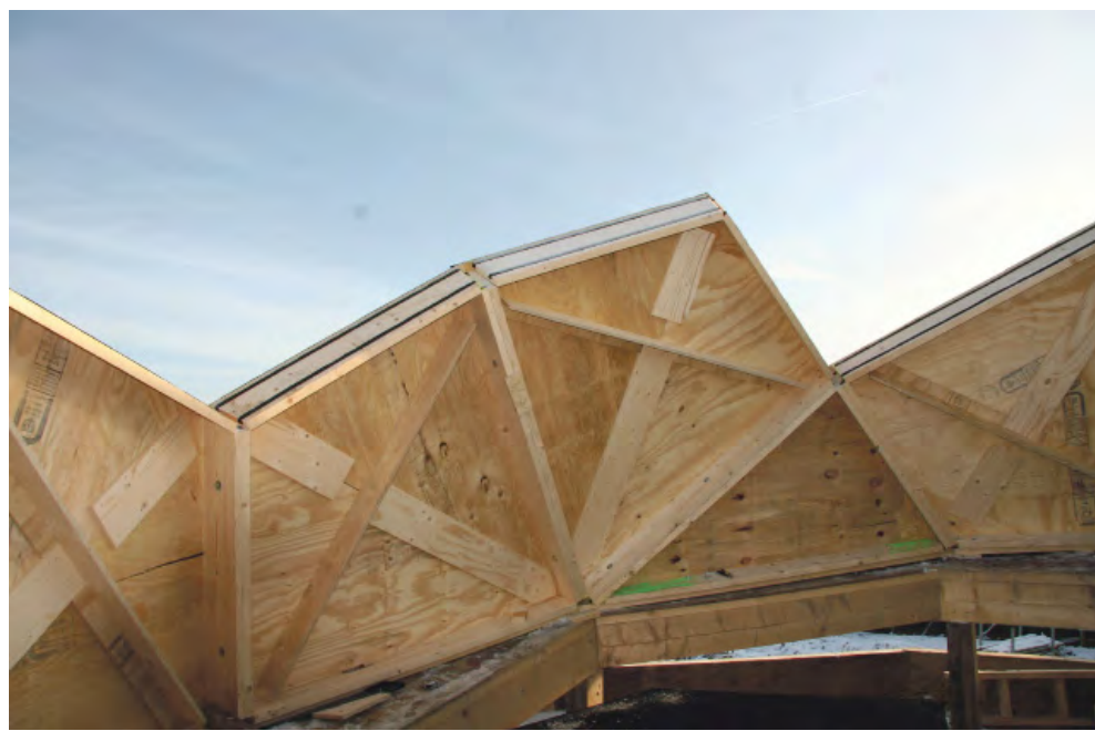
Een koepel op het dak zorgt voor 27 m 2 extra ruimte. De koepel bestaat uit houten vliegvormen.
