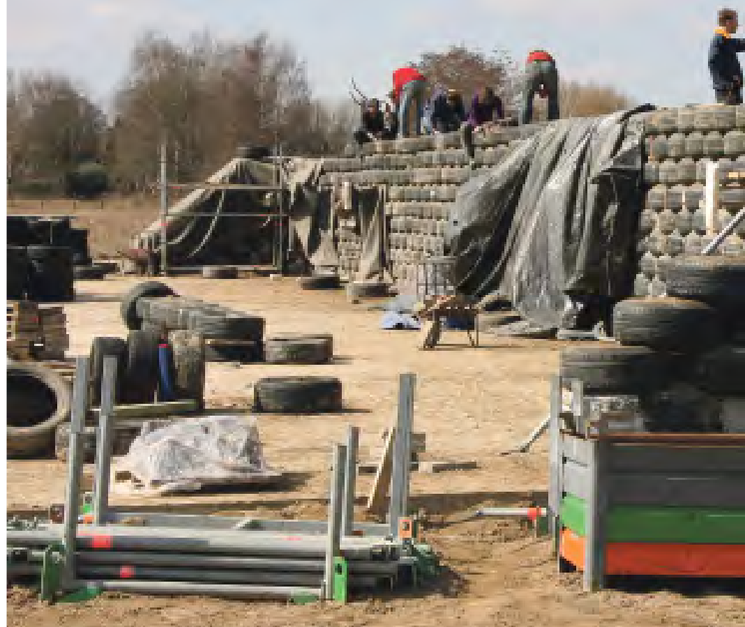
Op de betonnen begane grondvloer worden de bandenwanden gestapeld en volgestampt met zand.
