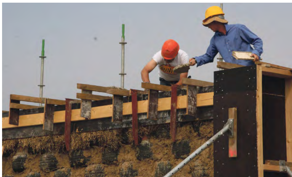
Over de bandenwand wordt ter plaatse een betonnen ringbalk gestort.
