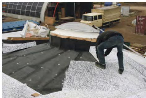
Door het rondlopen van de koepel is het aanbrengen van de isolatieplaten een hele puzzel.
