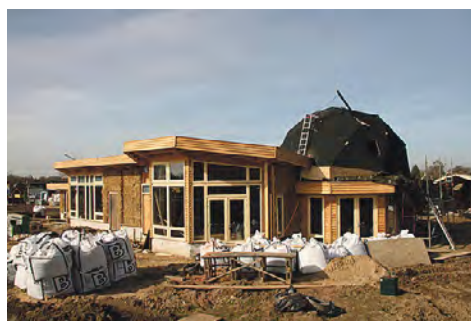
Aanzicht aan de zuid(zon)zijde van de twee woningen die nagenoeg opgeleverd zijn. Nu de afwerking binnen nog.
