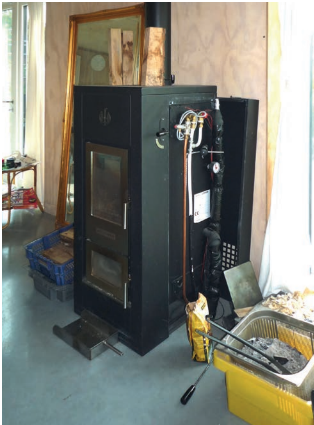
△ Het enige stukje koperen leiding zit bij de Waltherm Königsspitze Quick houtvergasser. Daar wordt de temperatuur te hoog voor de PEX-leiding.
