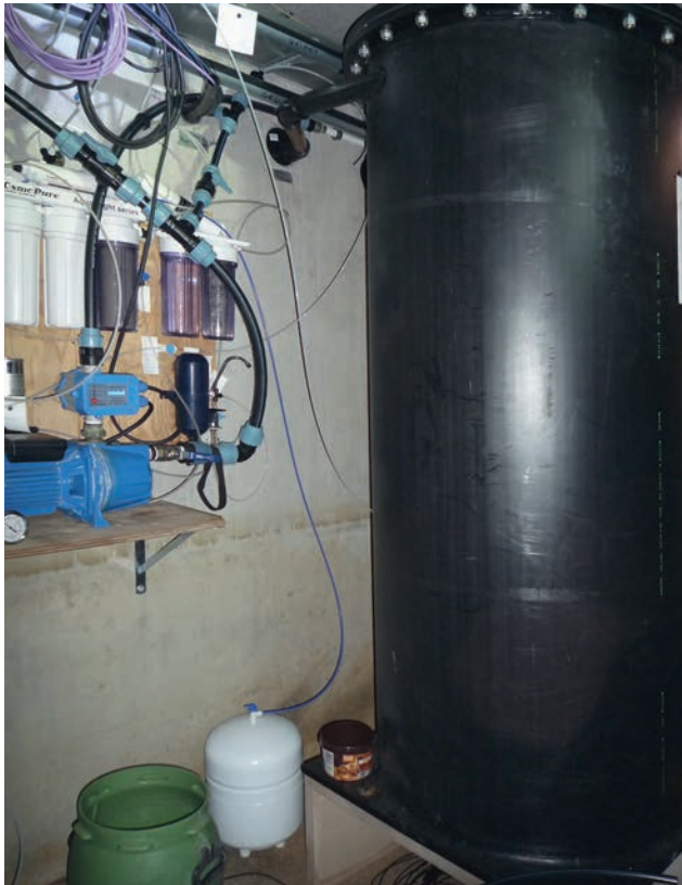
△ Het regenwater wordt via een osmosepomp gereinigd en in een drinkwatertankje van 10 liter opgeslagen.
