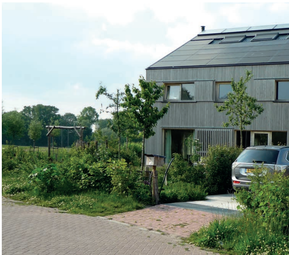
△ Direct onder de nok boven de pv-panelen ligt een rij vlakke plaat zonnecollectoren met een opbrengst van 27 GJ/a. Het dak moet eens in de twintig jaar worden vervangen.
